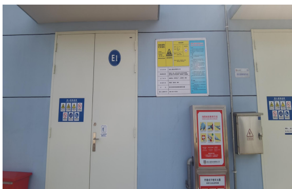
危险废物暂存间
