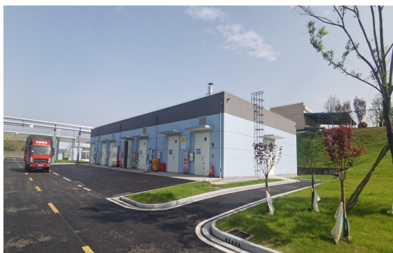
固废仓库（一般工业固废、危险废物）
