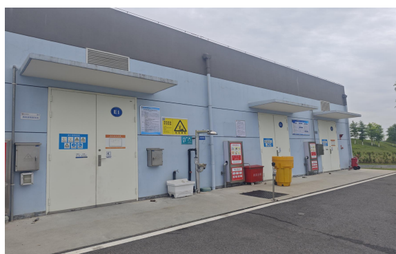
固体废物暂存间（依托，一般固废、危险废物）
