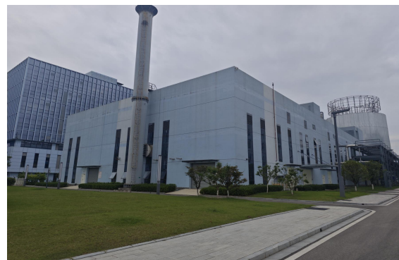
锅炉废气总排口 DA001（依托）
