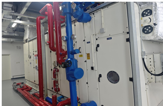
冻干制剂净化空调三系净化系统（初级、中级）
