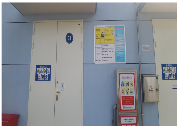
危险废物暂存间
