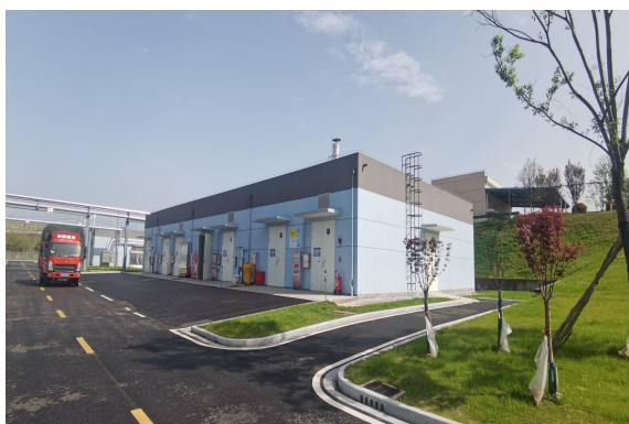
固废仓库（一般工业固废、危险废物）
